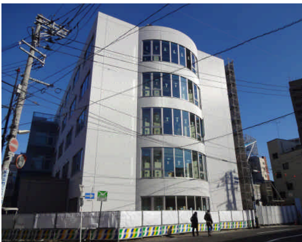
竣工間近の新長町病院
